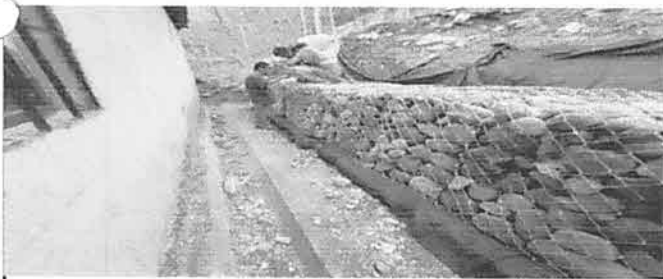
Foto 5: Se llena la primera fila de Gabiones
