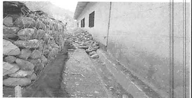
Foto 4: Se llenan los gabiones con piedra de rio .
