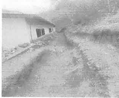
Foto 1: Se preparo el terreno para la colocacion de la primera fila de gabiones .
