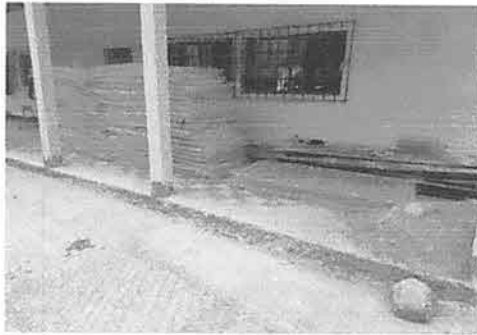
Foto 3: Se observa los gabiones .
