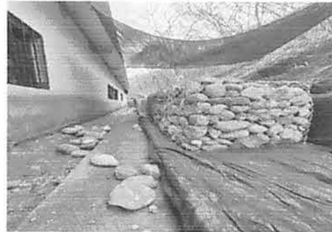
Foto 6: colocacion de gabiones con respectiva malla .
